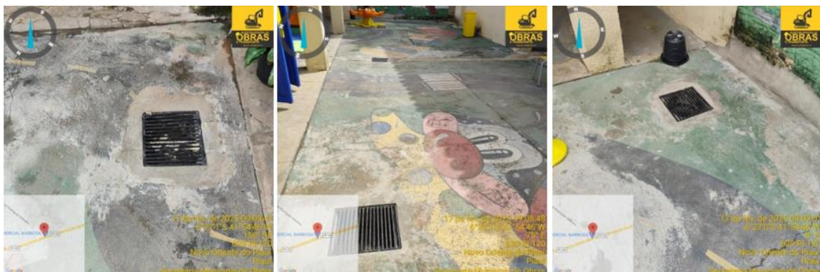
Figura 39 - Adequações estruturais na Creche 7 Anões
