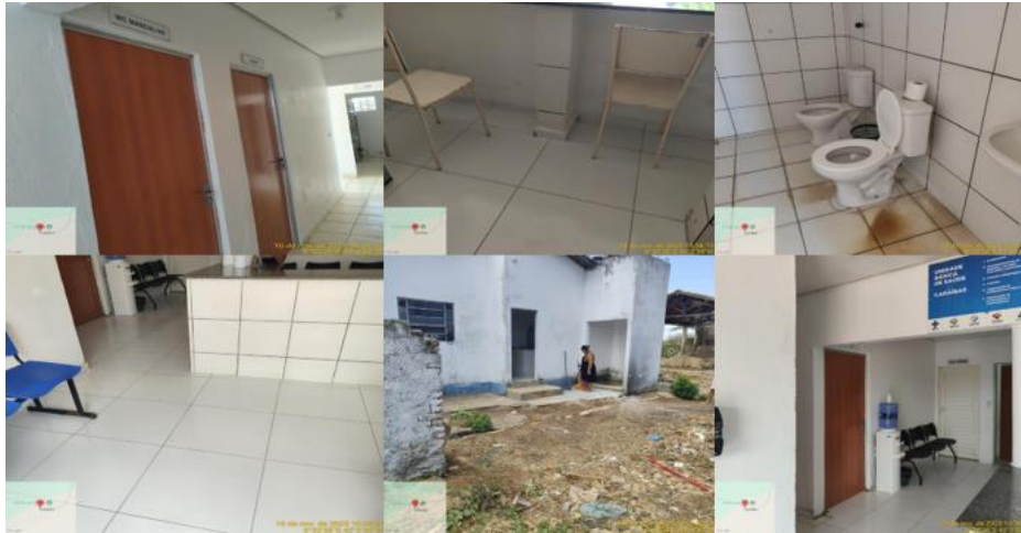
Figura 38 – Reparos estruturais na UBS de Caraíbas, 2025 (Antes x Depois)
