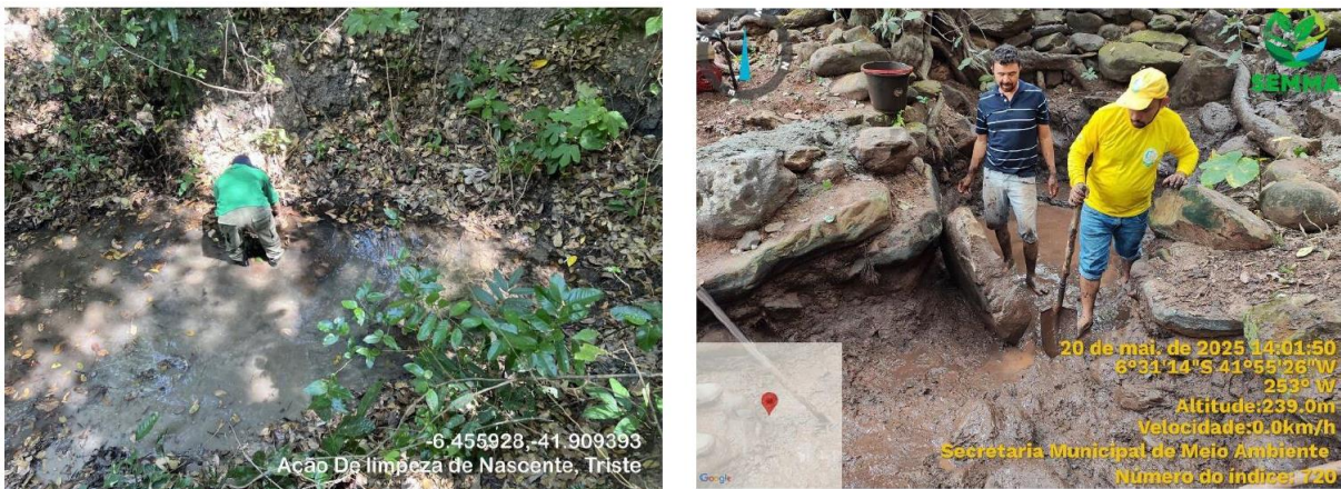
Figura 15 - Recuperação de nascentes (Urbana e Rural), 2025.
