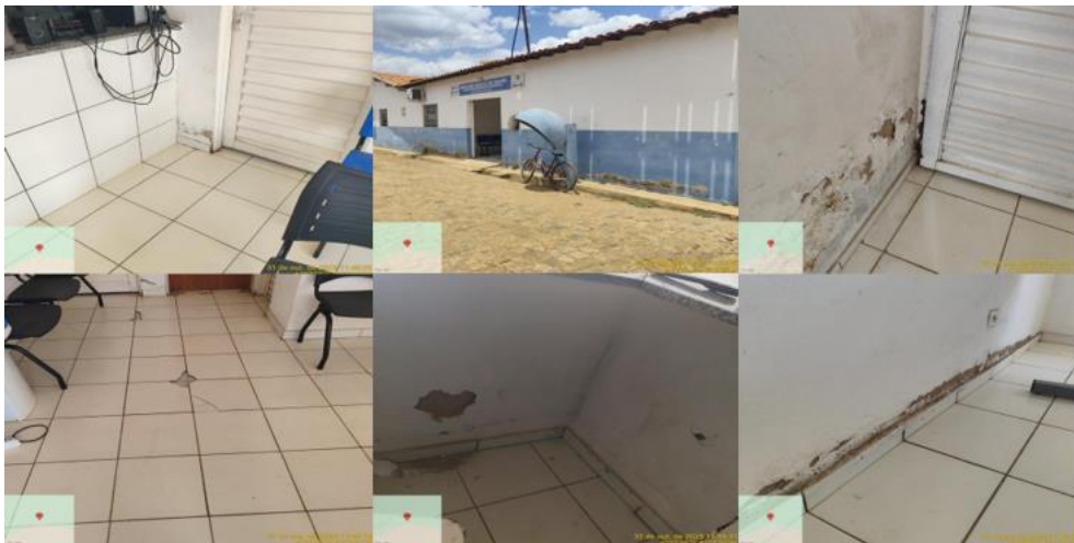
Figura 37 – Reparos estruturais na UBS de Caraíbas, 2025 (Antes x Depois)
