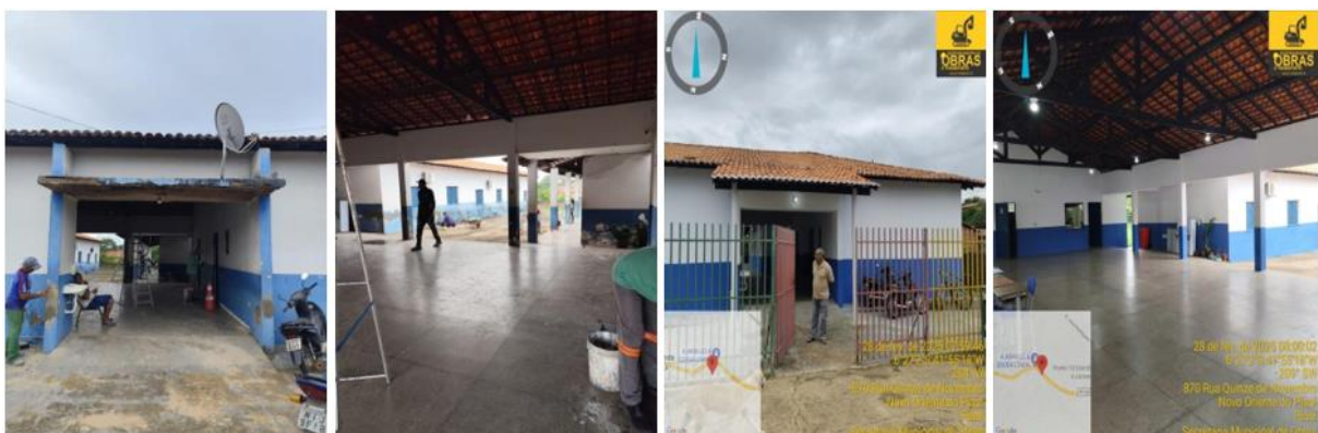
Figura 36 – Reforma Geral da Escola Adelaide, 2025.
