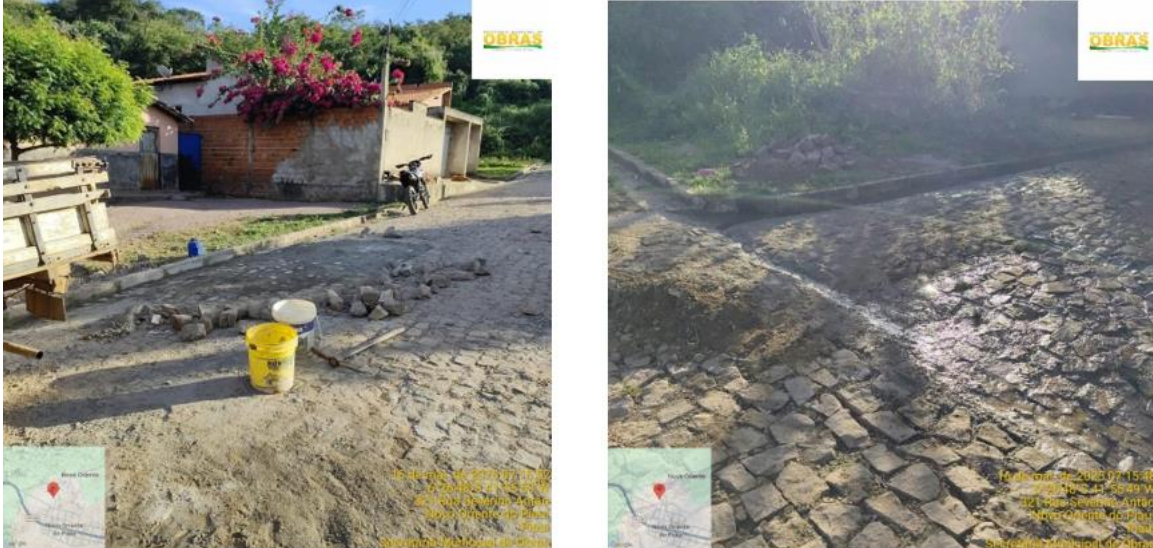
Figura 41 – Limpeza Urbana e Reforma em Calçamento Poliédrico
